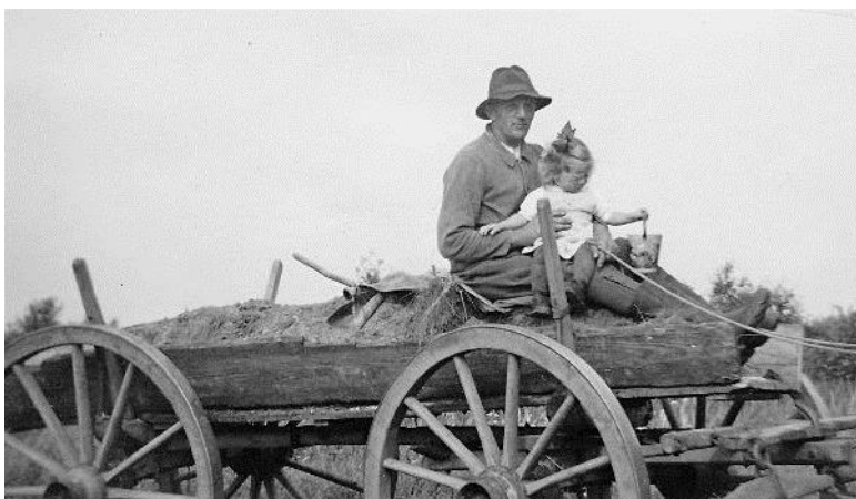
1951: Ein Leiterwagen, der als Bauwagen genutzt wird.
