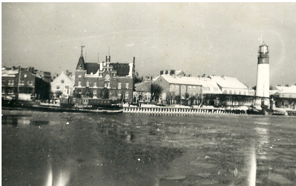
Der Hafen von Pillau mit dem Postgebäude und dem Leuchtturm
