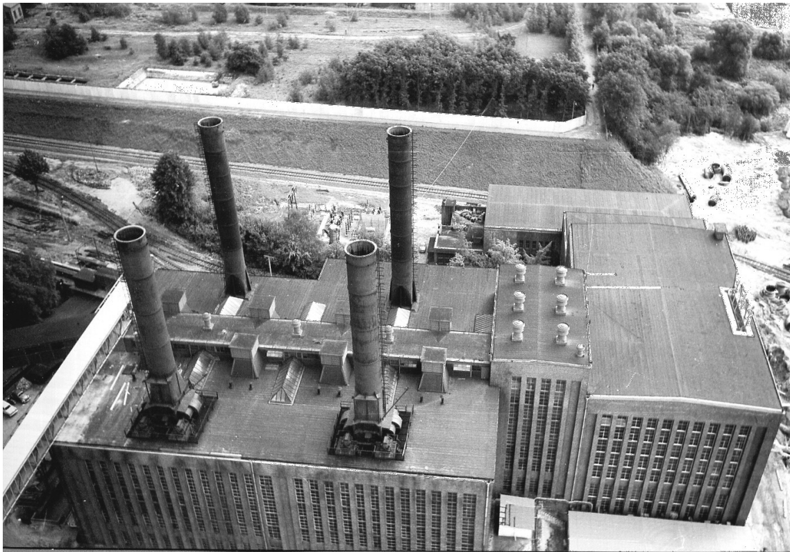
Bild 22: Das Kraftwerk 1937 in der 2. Ausbaustufe, als es schon an HEW verpachtet war
