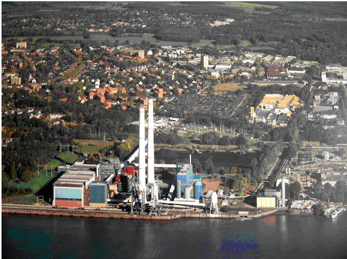
Bild 25: Kraftwerk nach 1998: Das Kraftwerk ist halb abgebaut. Der Rest ist vorwiegend nur noch Heizkraftwerk. Neu: Rauchgasentschwefelung in dem blauen Gebäude rechts der Schornsteine.
