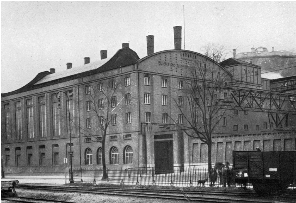
Bild 17: 1913: Elektrizitätswerk Unterelbe (EWU) in Altona-Neumühlen
