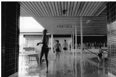
Foto: Bauamt, Hallenbad 1969
